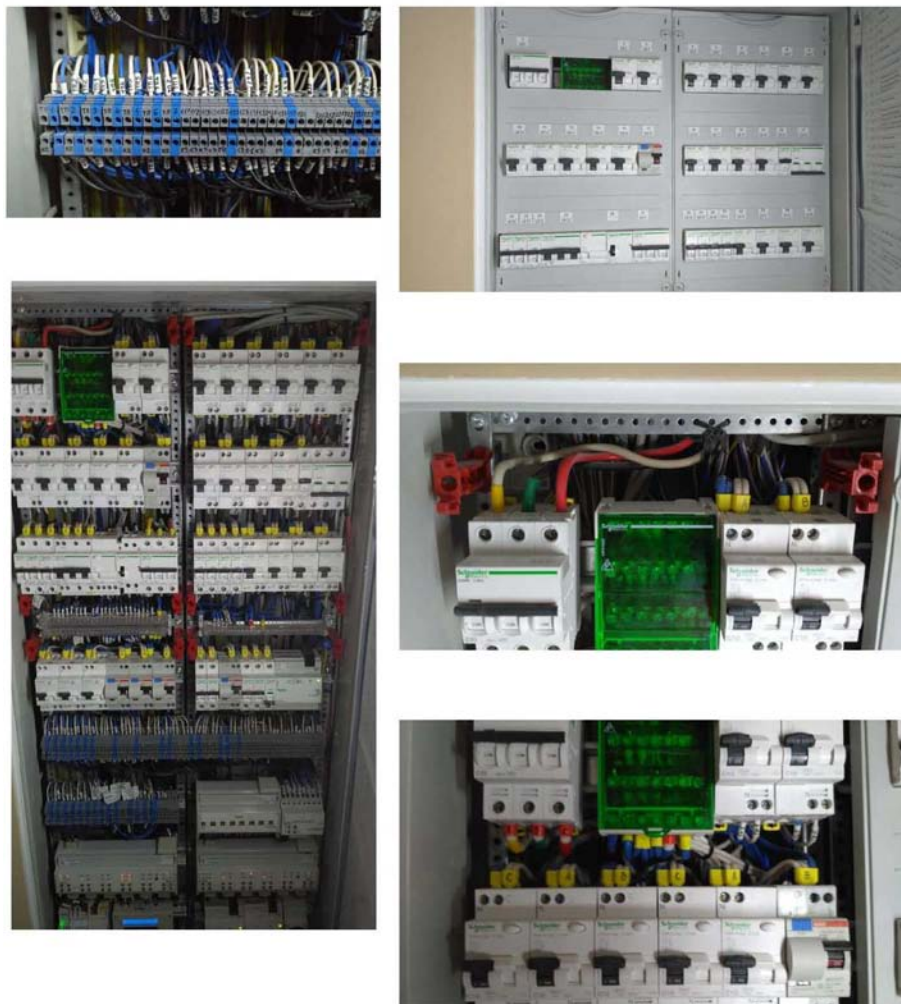
Монтаж электрического щита компании «Арт-Ин»
